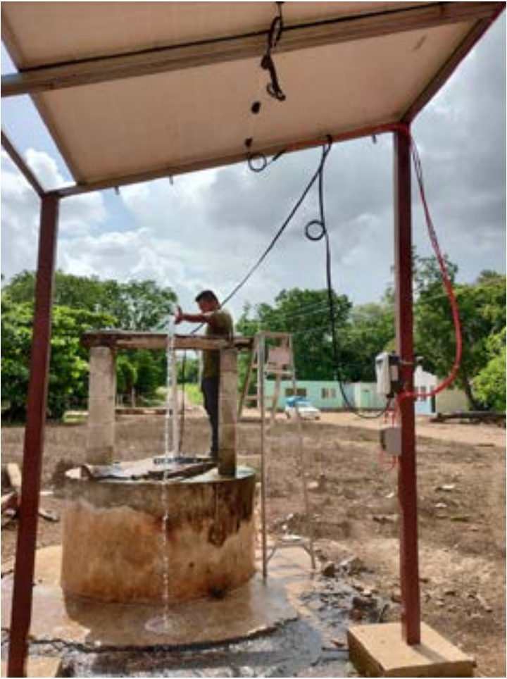
Bombas de agua alimentadas por energía solar.
